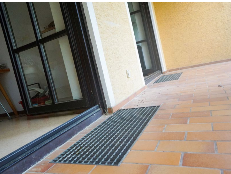
Abb. oben: Vor dem Umbau waren die Terrassentürschwelle innen 8 cm hoch und von außen 12 cm hoch. Rechts: Statt der hohen Schwelle/Türanschläge ermöglichen heute die aufgestockten Böden und die Magnet-Nullschwelle ohne Türanschlag eine barrierefreie Zugänglichkeit selbst mit den kleinen und harten Rädern des Stehbretts von Luise.
