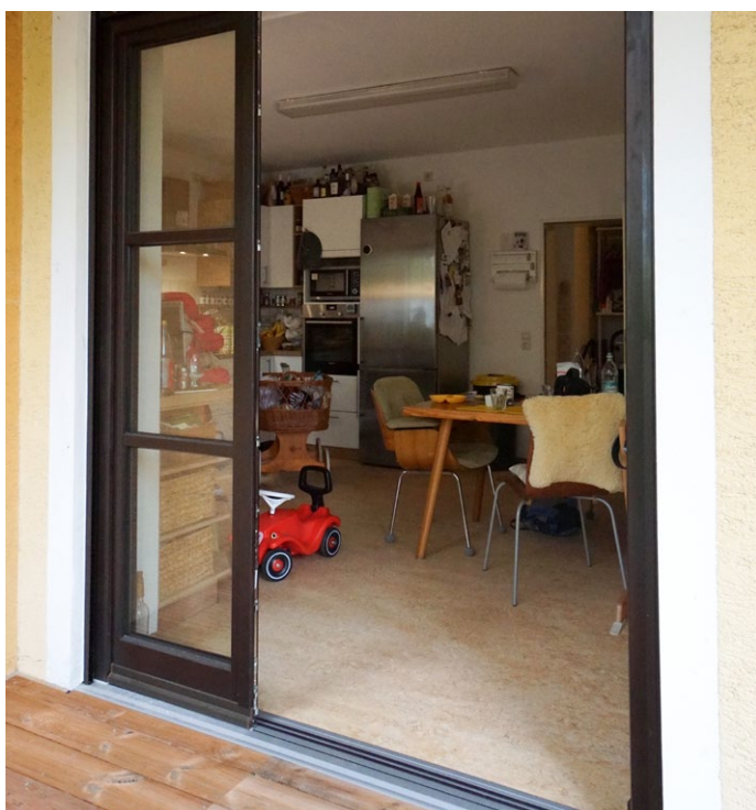
Abb. oben: Vor dem Umbau waren die Terrassentürschwelle innen 8 cm hoch und von außen 12 cm hoch. Rechts: Statt der hohen Schwelle/Türanschläge ermöglichen heute die aufgestockten Böden und die Magnet-Nullschwelle ohne Türanschlag eine barrierefreie Zugänglichkeit selbst mit den kleinen und harten Rädern des Stehbretts von Luise.
